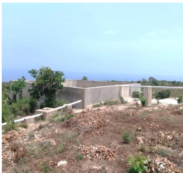
Figure 13 : Vue du réservoir de Rangommier
