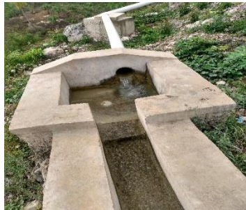
Figure 11 : Bassin de distribution
