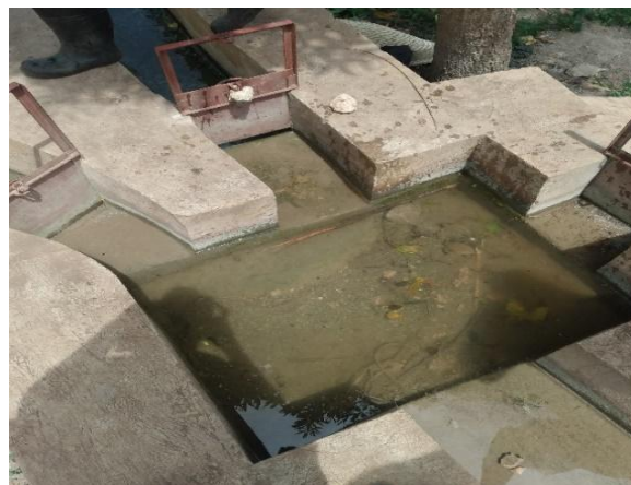
Figure 12 : Vue du bassin de distribution du canal Digoterie
