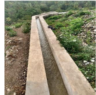
Figure 9 : Vue du canal primaire en maçonnerie
