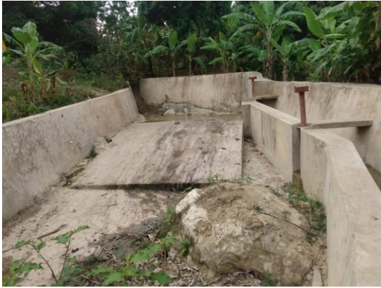
Figure 7 : Vue du seuil de dérivation
