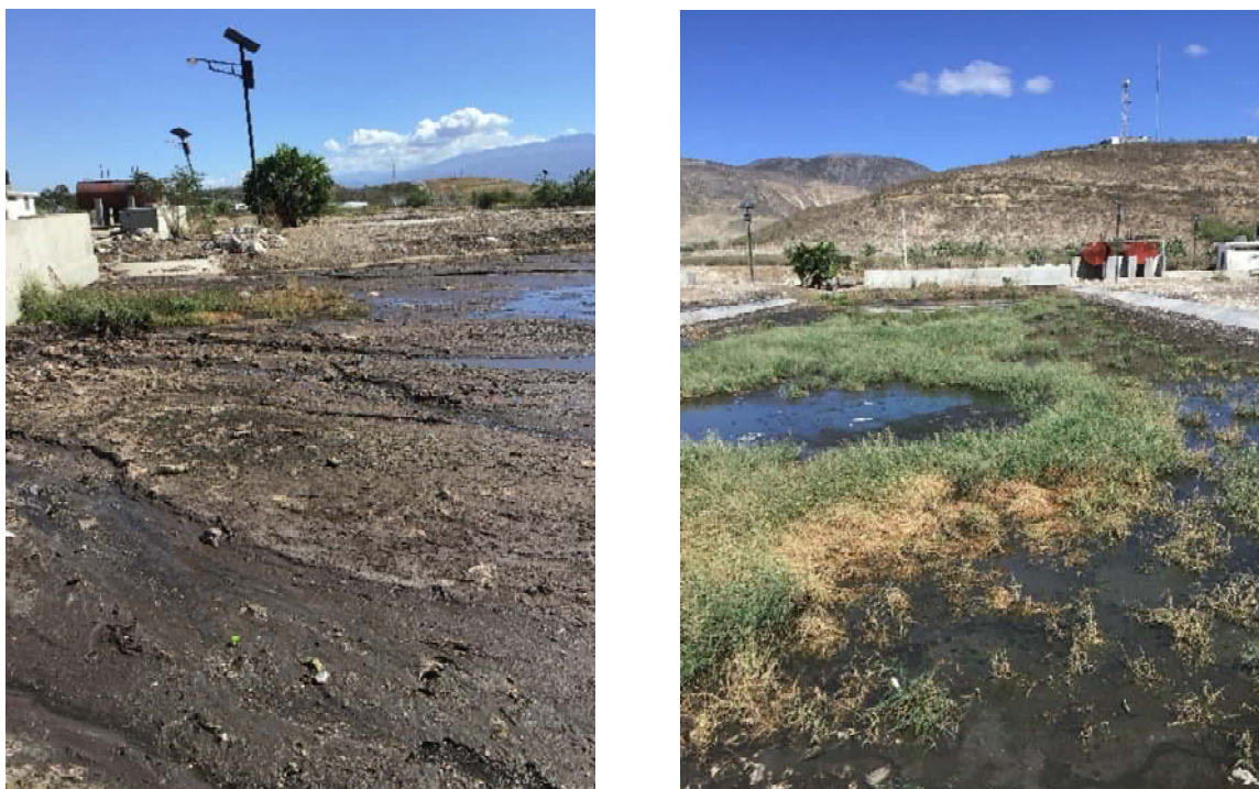
Figure 1. Bassins anaérobies remplis de boues à Morne-à-Cabri
