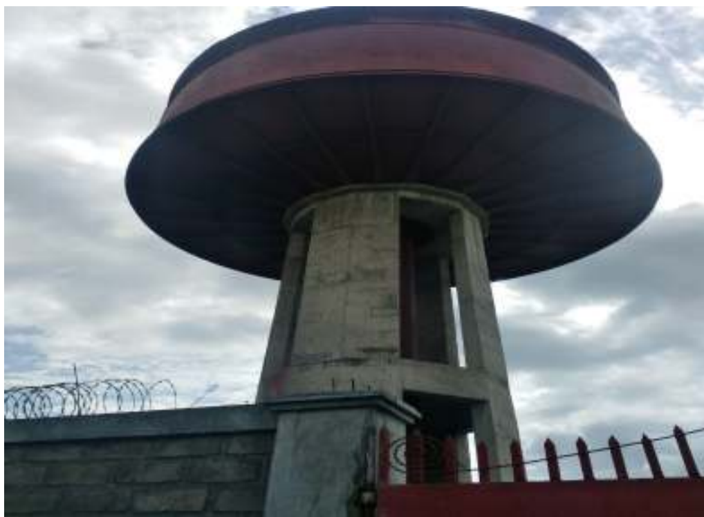
Figure 1 : Réservoir de 700 m3 la Savane
