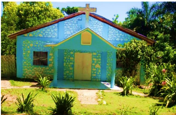
Figure 2: Vue de l'église Notre dame Alta grâce de Layaille
