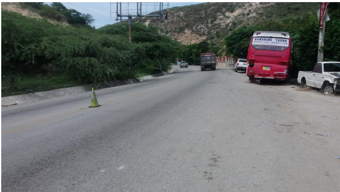
Réhabilitation du tronçon de route Saint-Marc/Gonaïves
