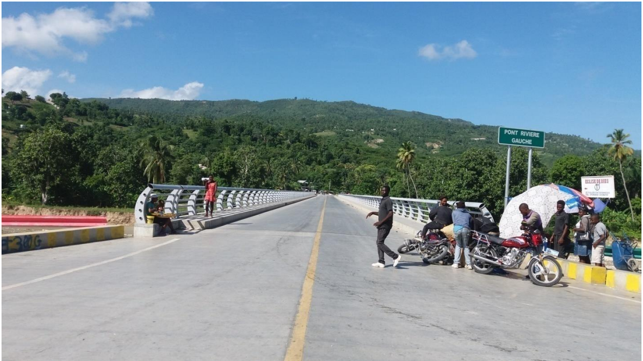
Entrée du pont de la rivière gauche
