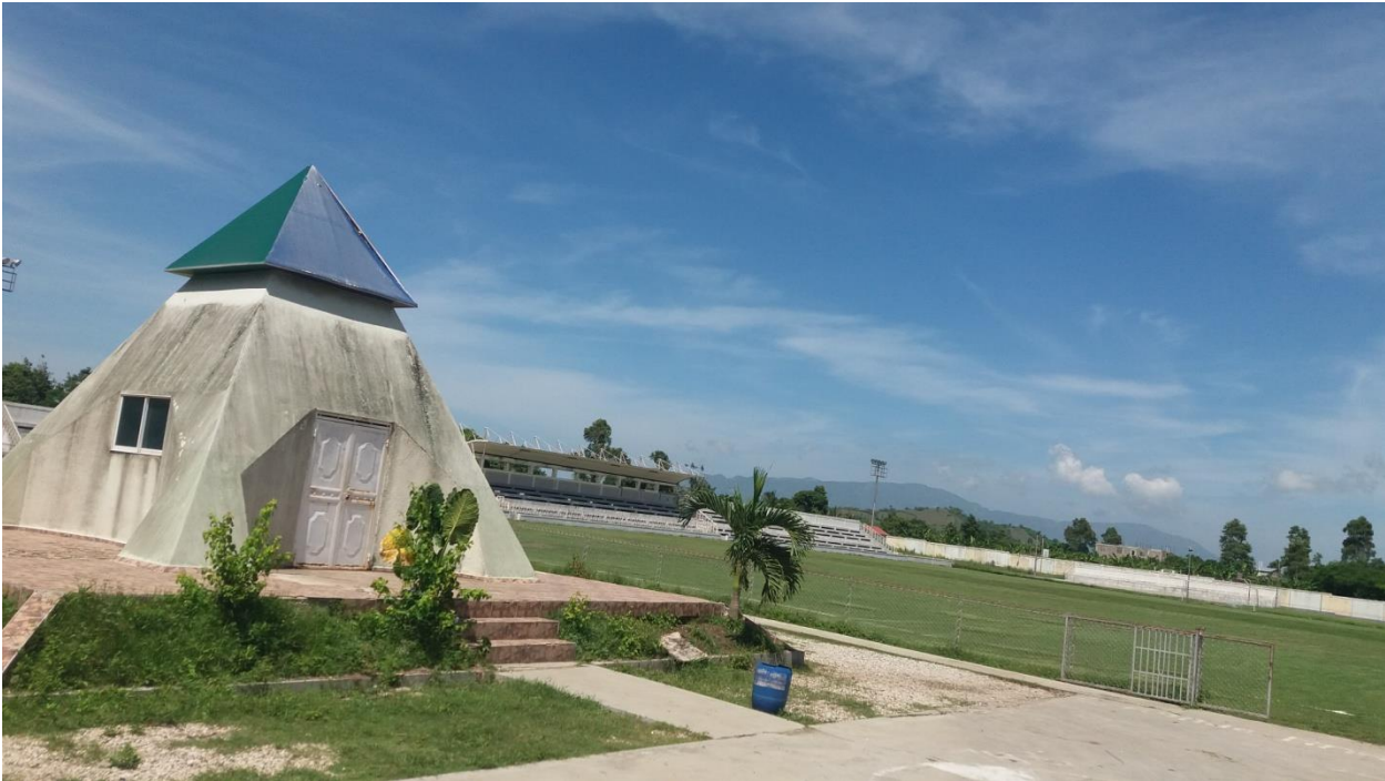
Infrastructure du parc sportif de Milot
