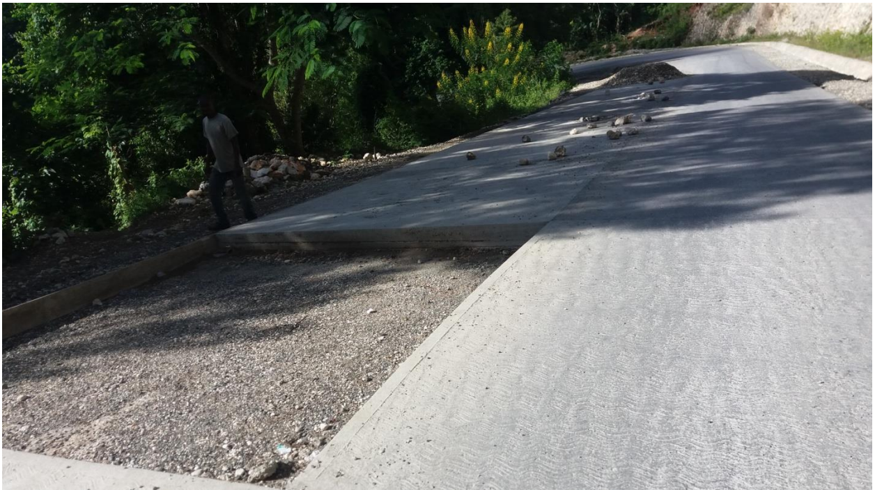
Béton hydraulique inachevé
