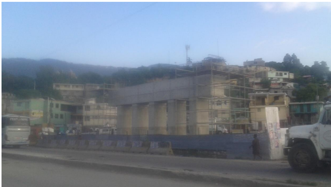
Le chantier de construction du viaduc de la Marine Haïtienne en cours
