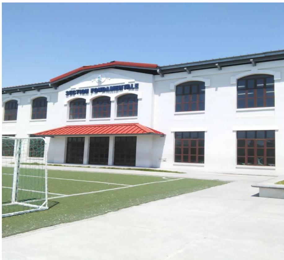
Façade nord du lycée Toussaint Louverture
