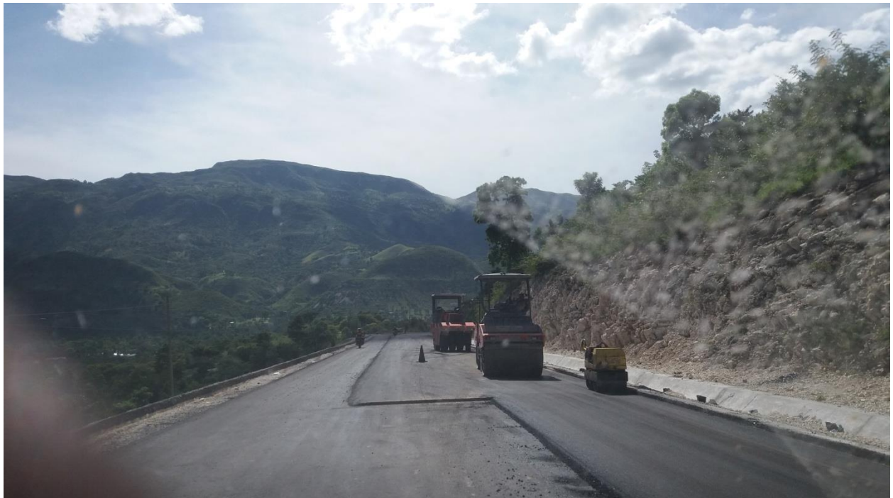
Travaux de réhabilitation de la route Ennery-Cap-Haitien.
