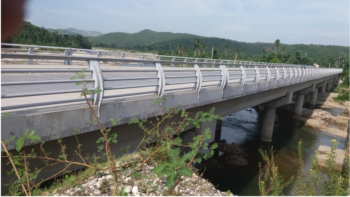
Pont Voldroque de profil
