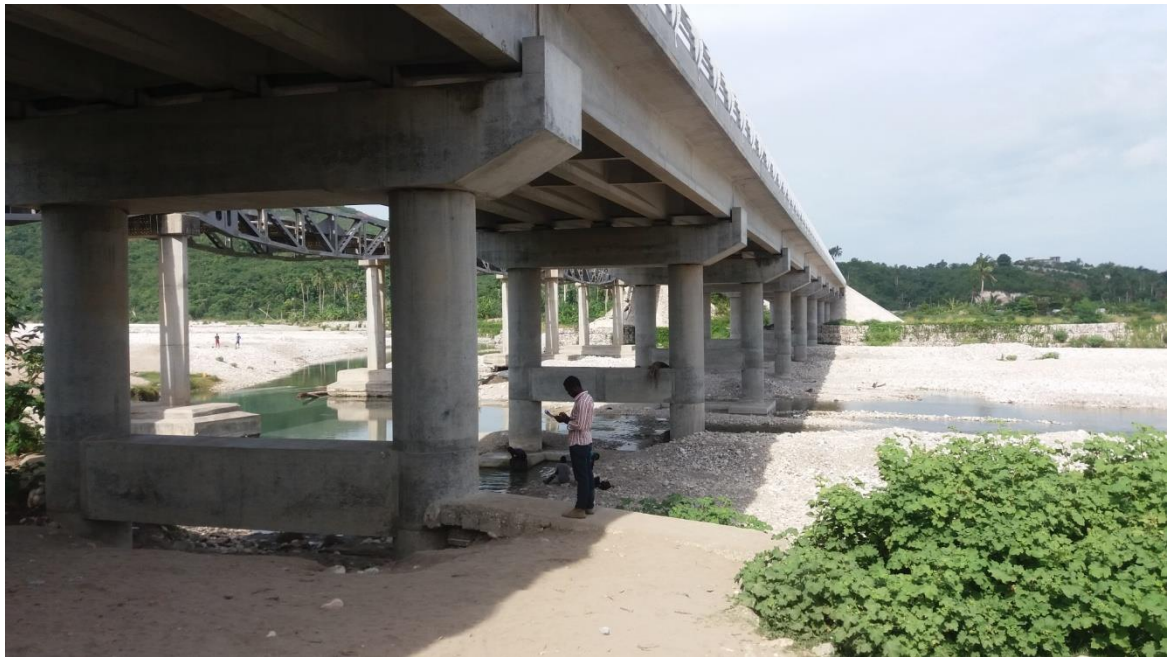
Infrastructure du pont Voldrogue
