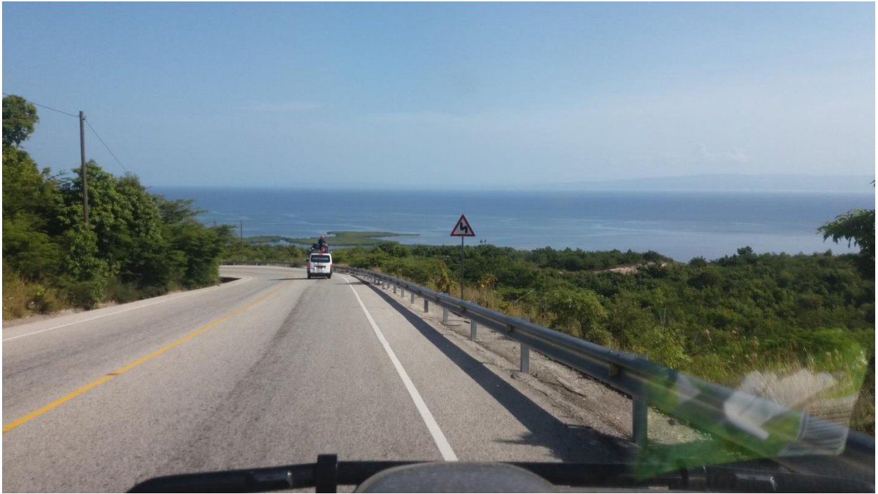
Existence de la signalisation
