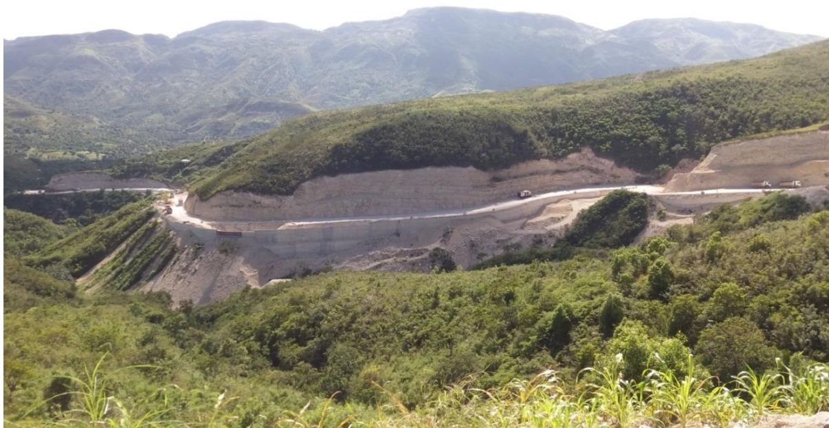
Travaux de terrassement du tronçon Ennery-Cap-Haitien, Puilboreau versant sud
