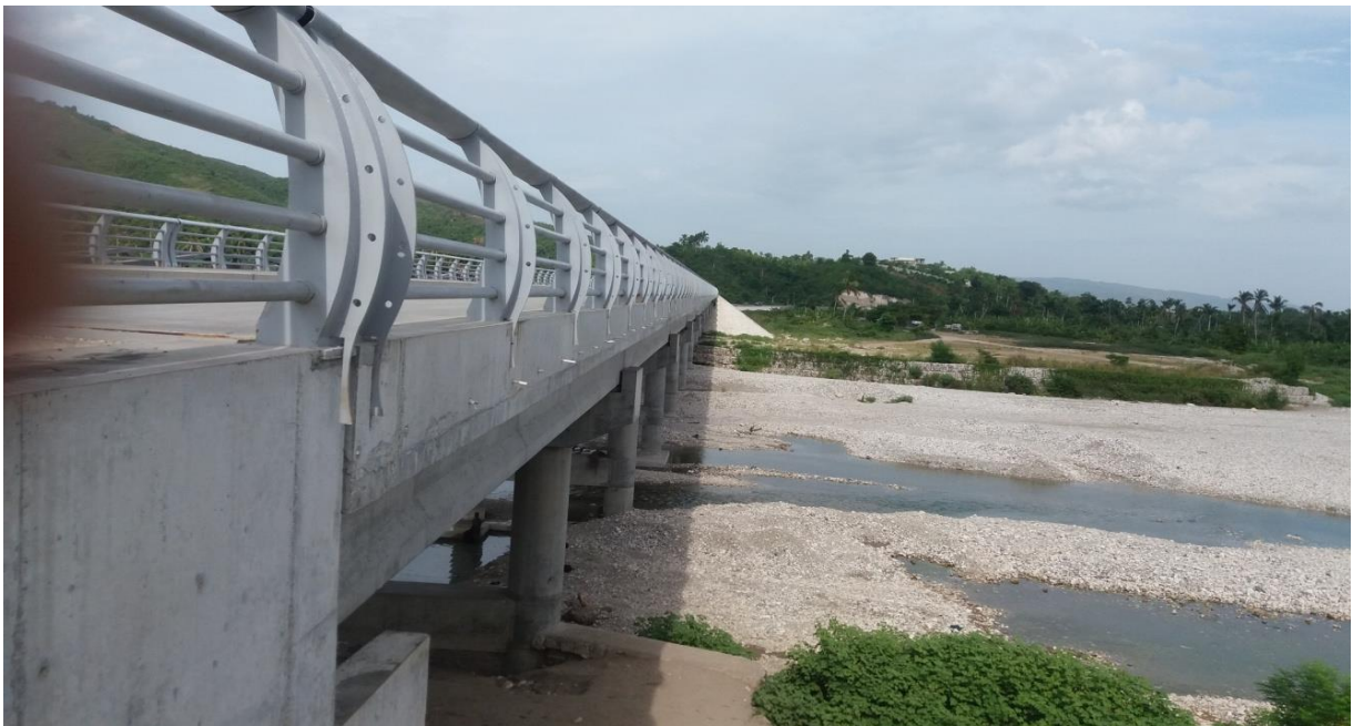
Pont Roseau de profil
