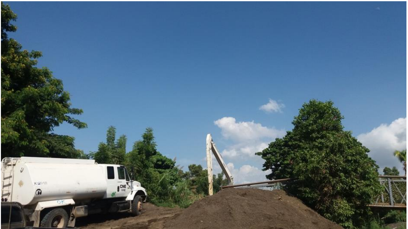
Le CNE aux travaux de dragage de la rivière
