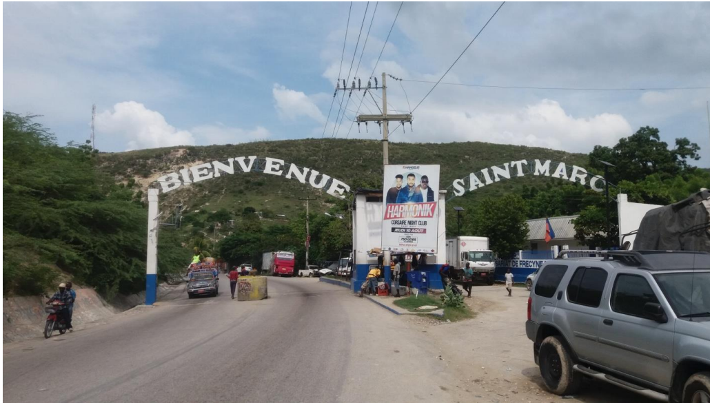
Réhabilitation de la route Frécyneau Saint-Marc
