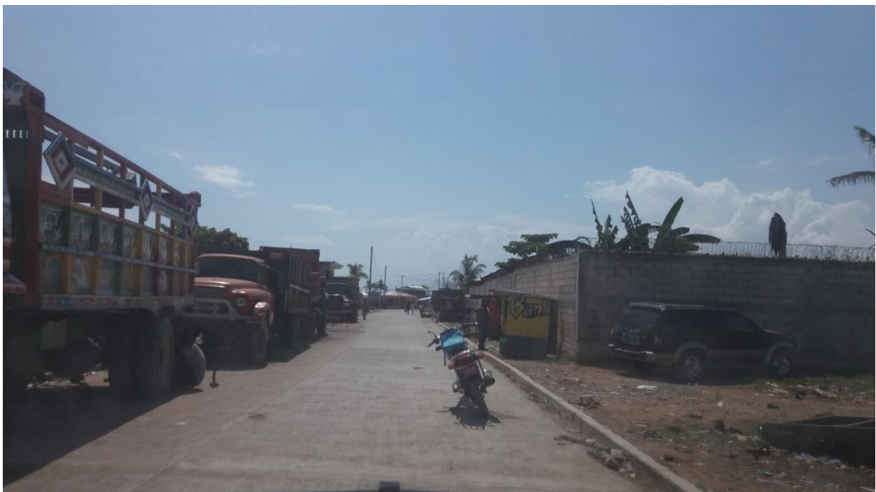
Vue d'une rue bétonnée inachevée
