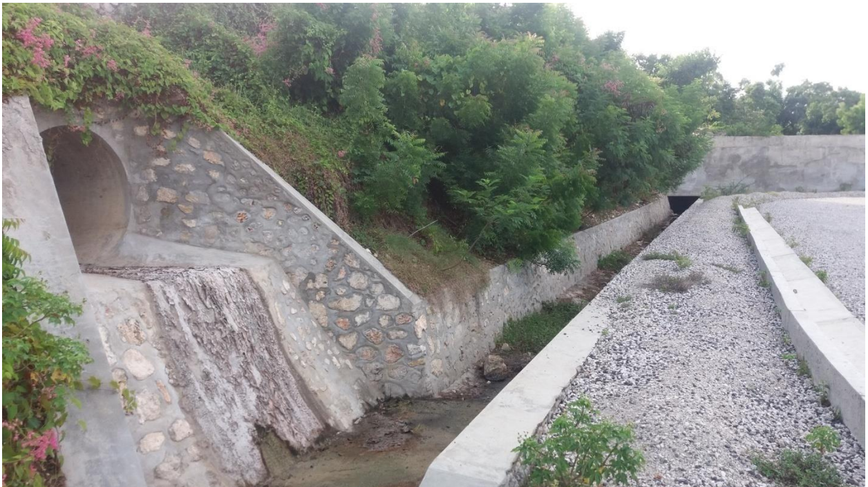
Drainage de la gare de Miragoâne
