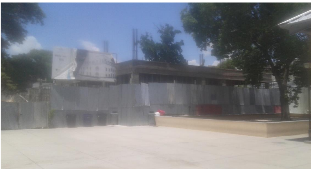
Partie inachevée du lycée
