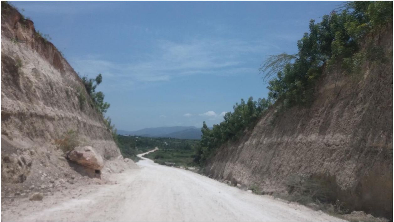
Travaux de terrassement du tronçon Petite-Rivière/Petit-Trou de Nippes
