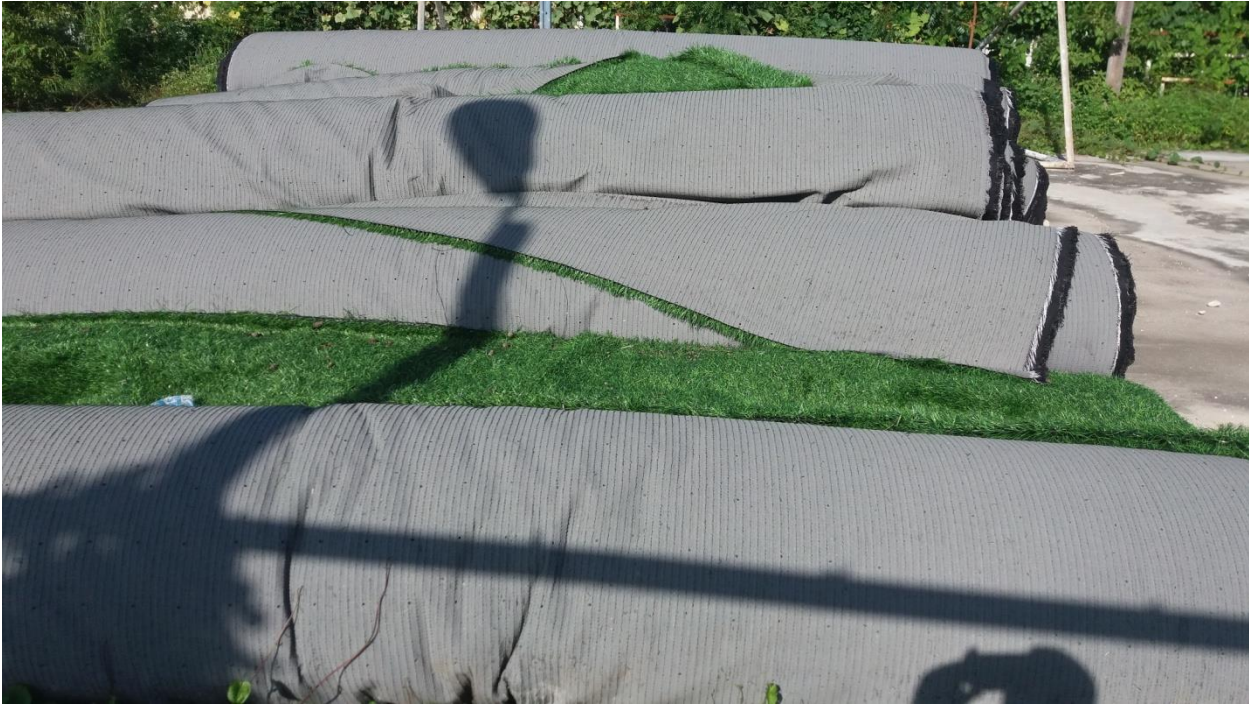
Gazon synthétique sur le site du parc de Gressier
