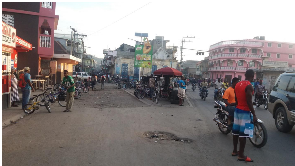
Rue en mauvais état de la ville du Cap
