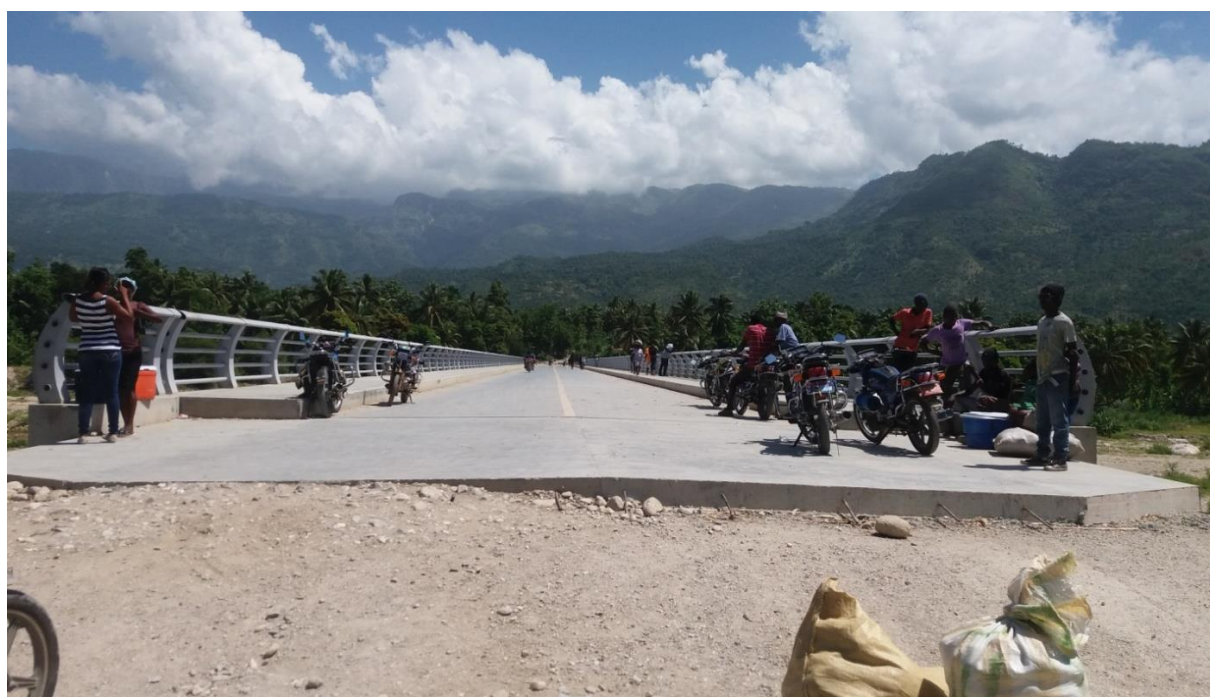
Le pont de Marigot (Péredo)
