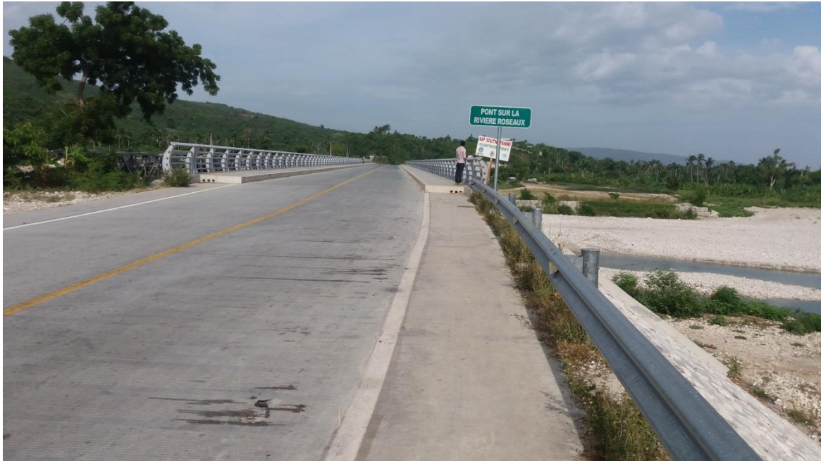
Entrée du pont Roseau
