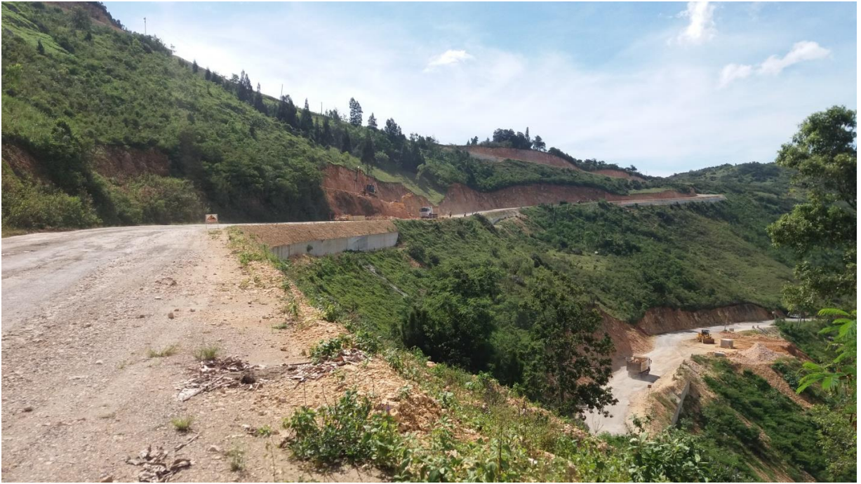
Travaux de terrassement du tronçon Ennery-Cap-Haitien, Pulboreau versant Nord.
