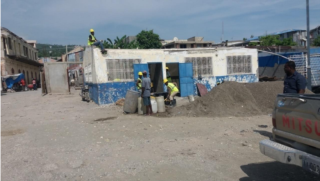
Construction du bureau de douane de Jérémie
