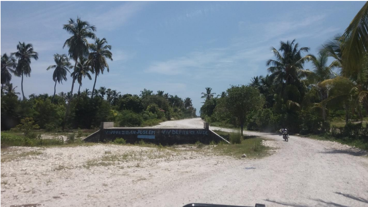
Dalot en construction non achevé du tronçon Petite-Rivière/Petit-Trou
