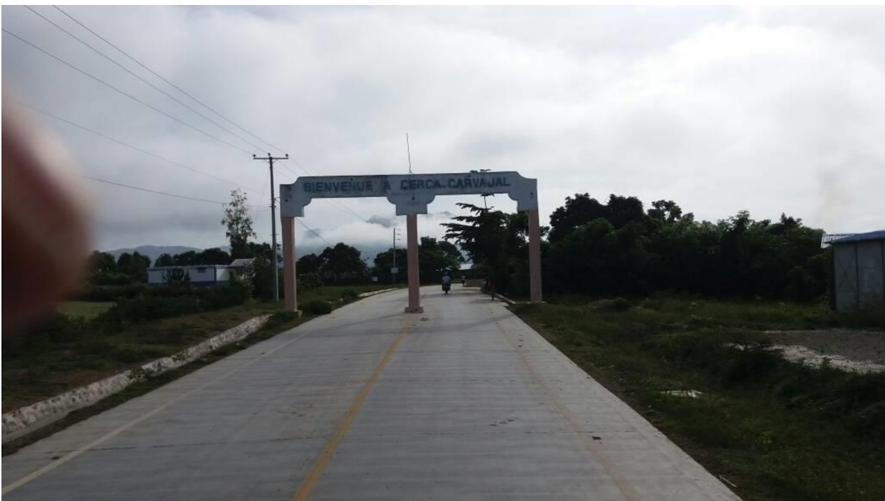
Route de Cerca-Cavajal en béton hydraulique
