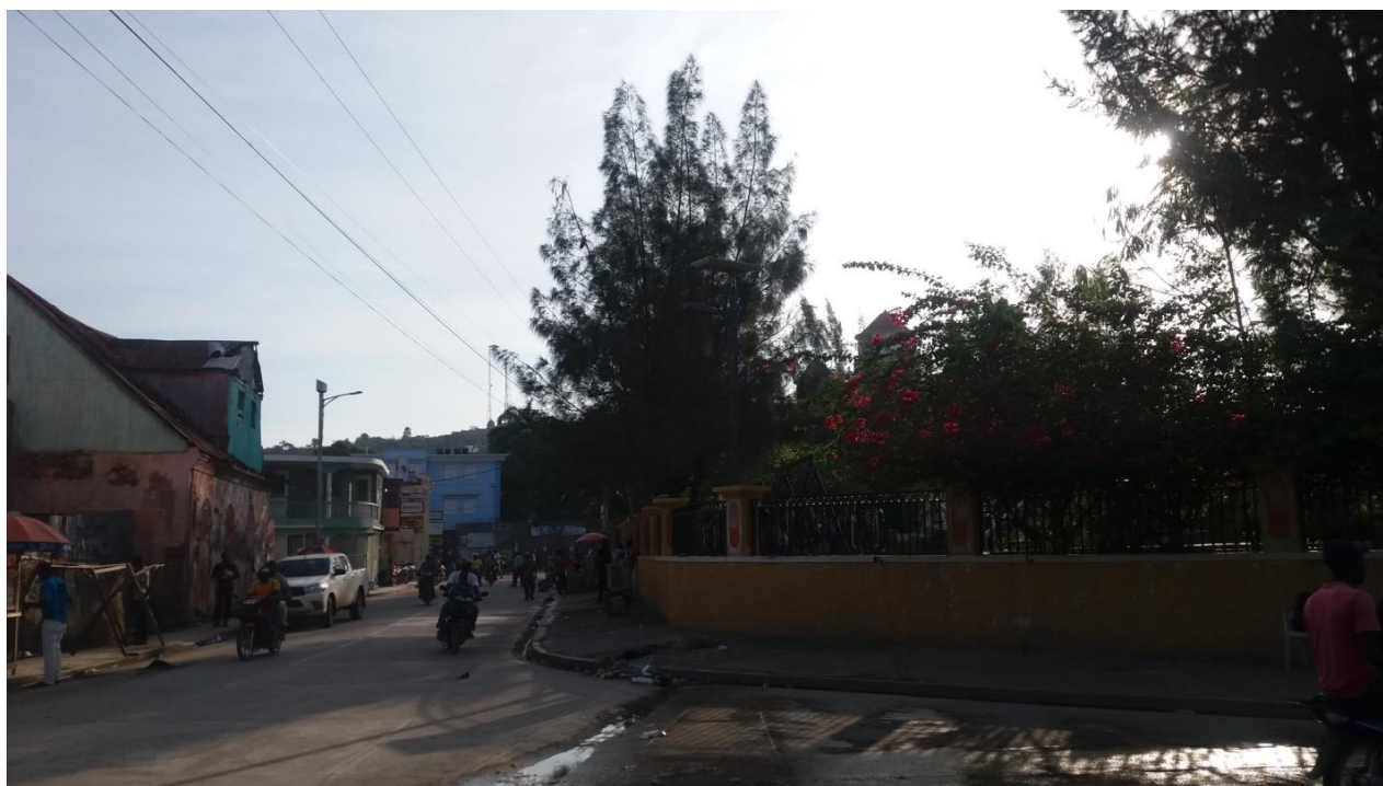
Rue réhabilitée de la ville de Port-de-Paix
