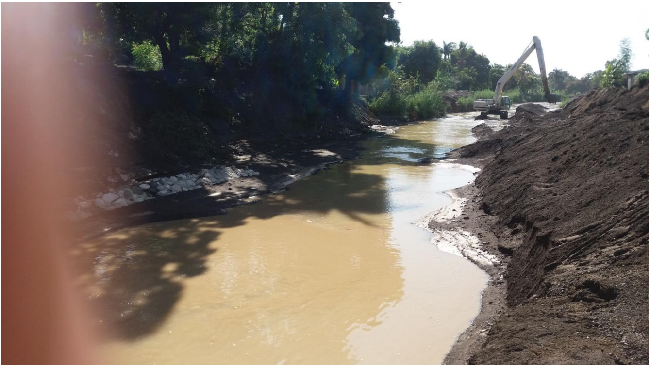
Dragage de la rivière en cours de réalisation
