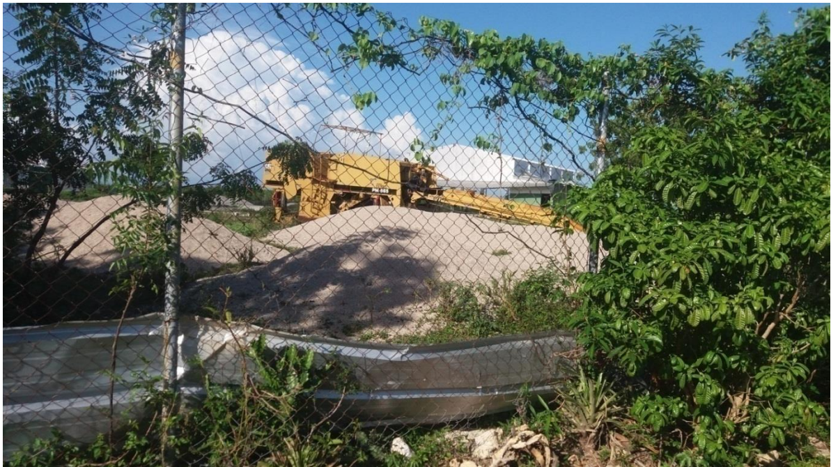
Matériaux restants sur le site
