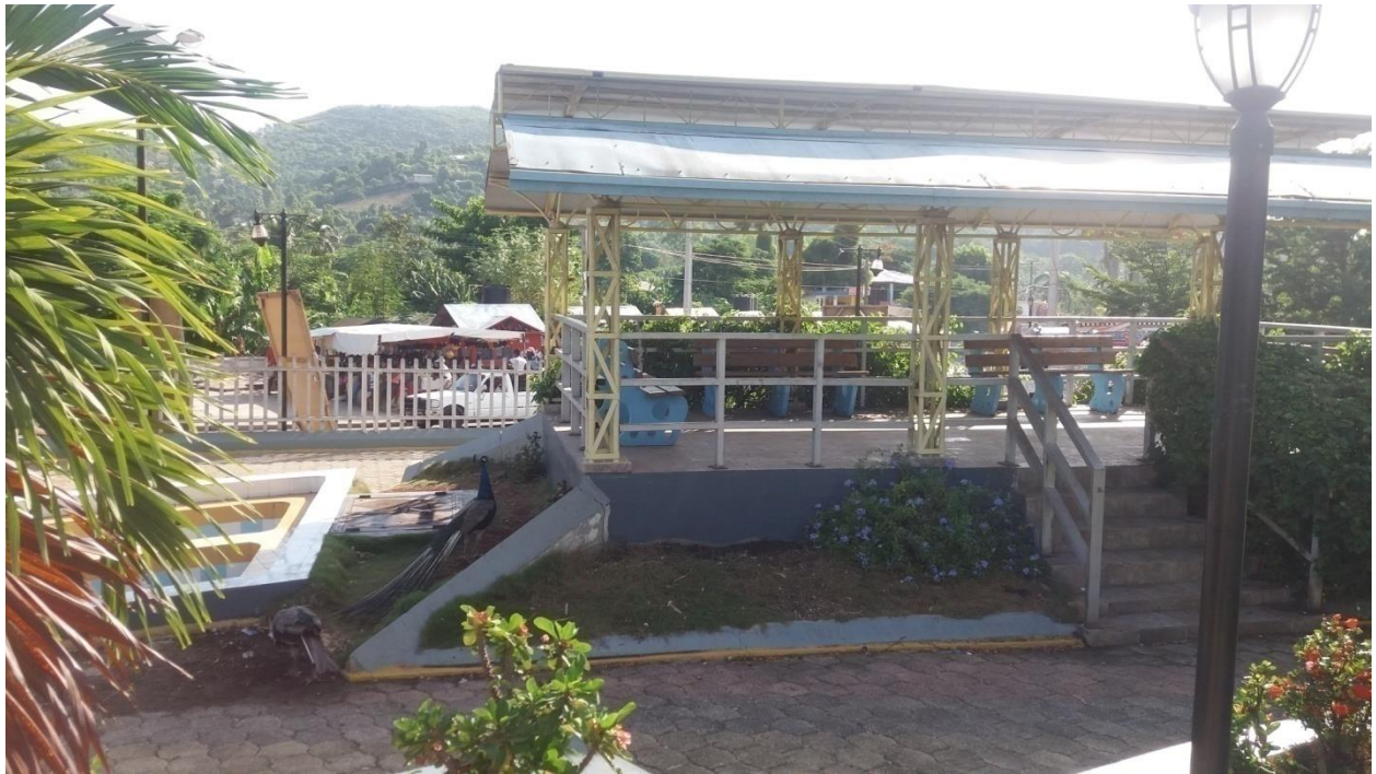
Partie Est de la place de carrefour Desruisseaux
