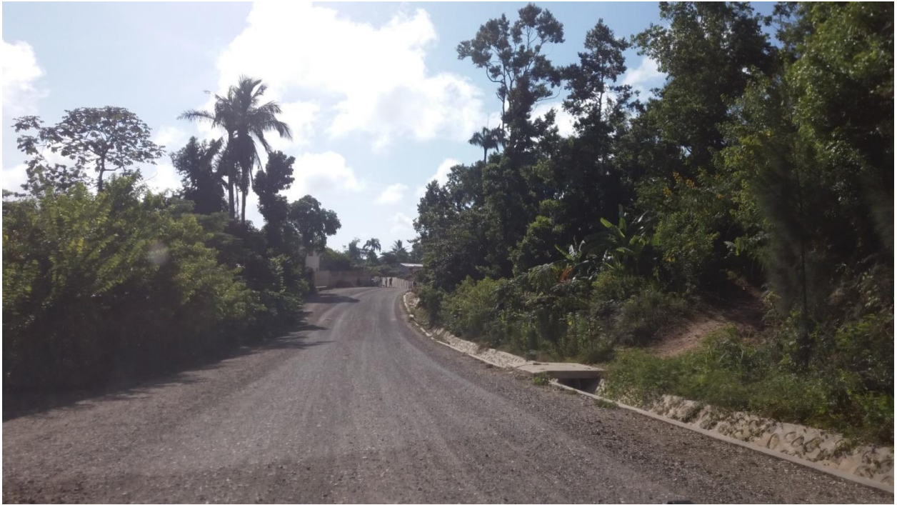
Une section des tronçons non bétonnés
